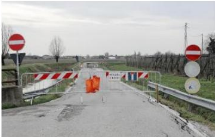
Via Colombarotto chiusa al traffico dopo i cedimenti della banchina
