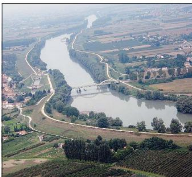
L'Adige all'altezza di Badia Polesine, dove è prevista la diga
