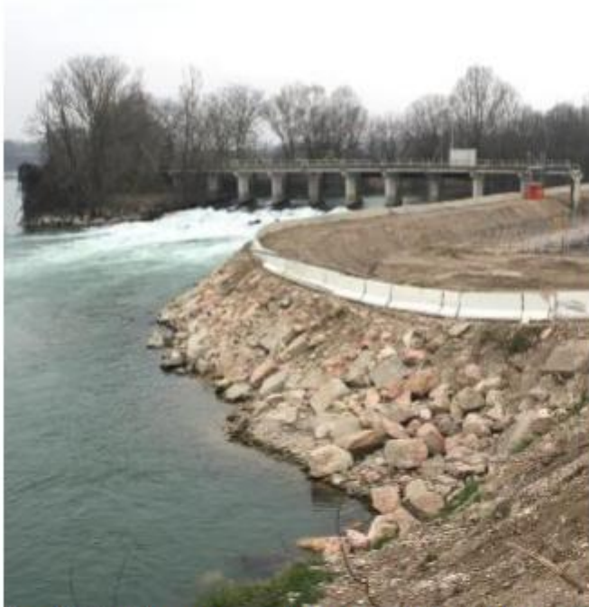
Lungo l'Adige c'è un nuovo progetto per una centrale idroelettrica
