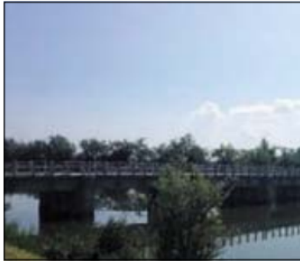
PORTO VIRO Il ponte Gramignara
