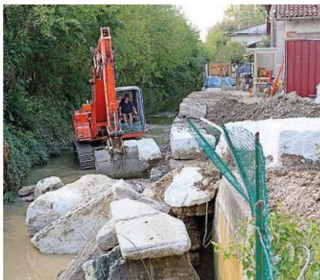
I lavori in corso di realizzazione nell'Avenale
