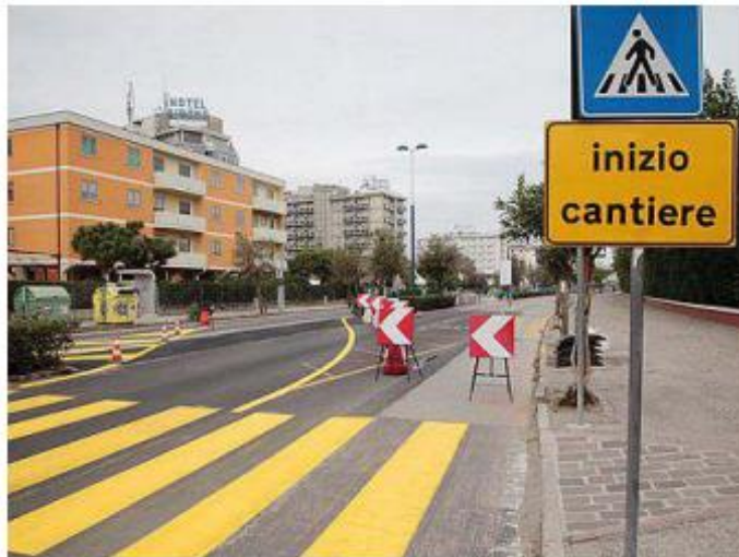
Riapre il cantiere per il "megatubo" contro gli allagamenti (foto Pòrcile)
