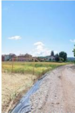
Cantiere per il vallo in Ca' Tosate
