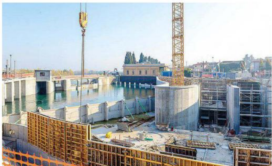
Il cantiere della centrale idroelettrica del consorzio di bonifica Piave a Nervesa
