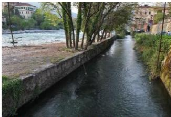
Il canale dove sarà realizzata la centralina sul Brenta
