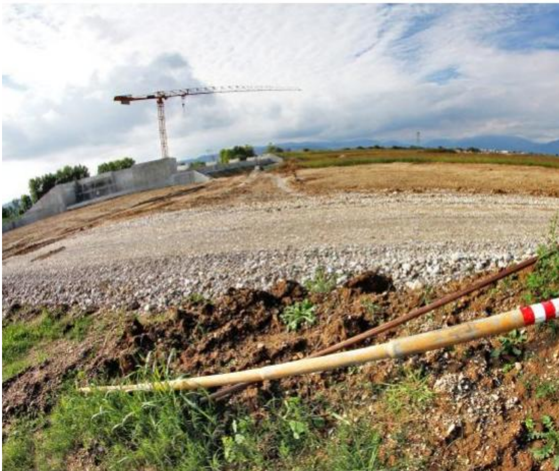
L'area dove sono in corso i lavori per la realizzazione del bacino di Caldogeno. FOTO STUDIOSTELLA
