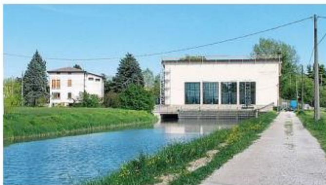
L'impianto idrovoro di Brentelle
