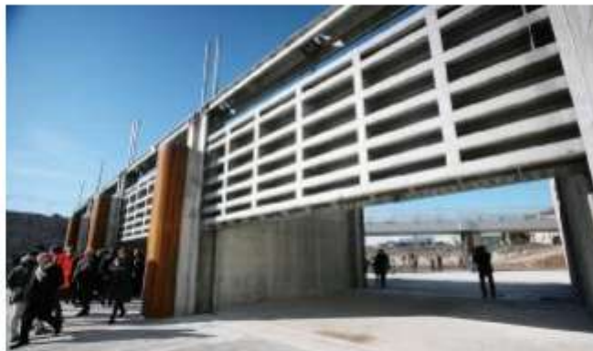
Le paratoie mobili da 8,5 tonnellate l'una, già collaudate. FOTO IMPIUMI
