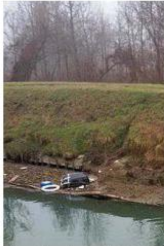
Gli argini erosi e sporchi a Fiesso
