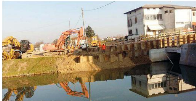
I lavori per la realizzazione della nuova idrovora dell'impianto di Brentelle
