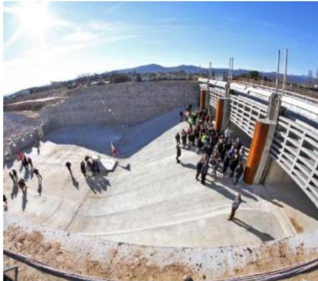
Le paratoie mobili del bacino anti-pienu di Caldogno
