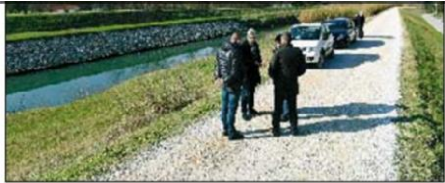
SOPRALLUOGO La delegazione regionale ieri a Rincajette: argini più sicuri
