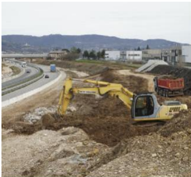
Un tratto del cantiere di lavoro della Pedemontana Veneta
