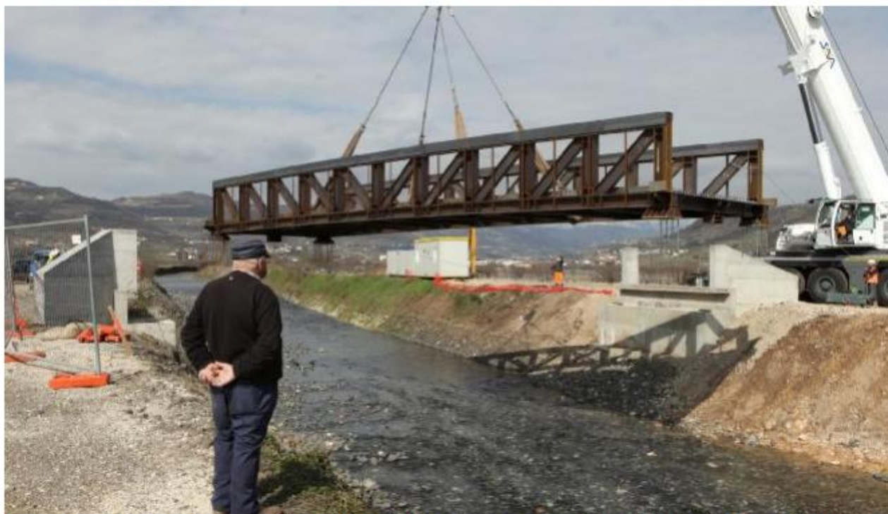
La posa del ponte di 26 tonnellate, passaggio sopra l'Alpone, al bacino Colombaretta, per permettere i lavori anti alluvione dell'Alpone AMATO
