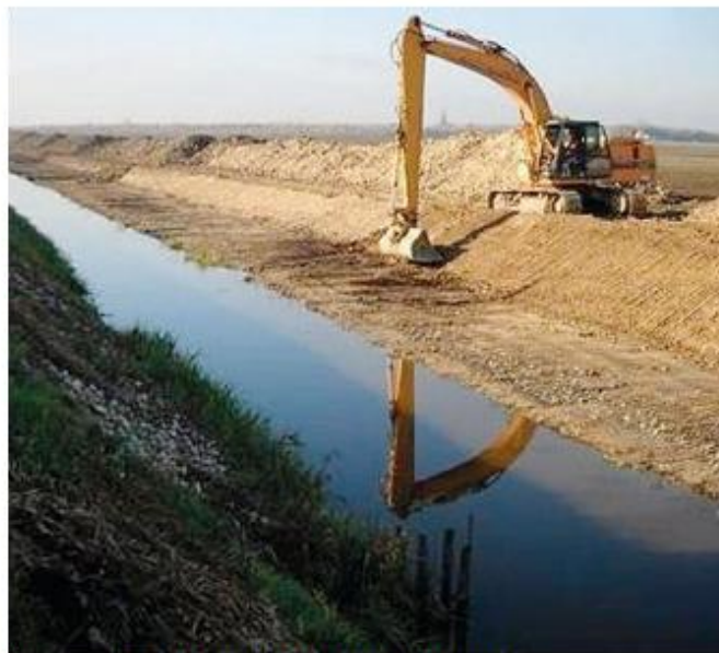
Operazioni di sistemazione delle sponde di un canale
