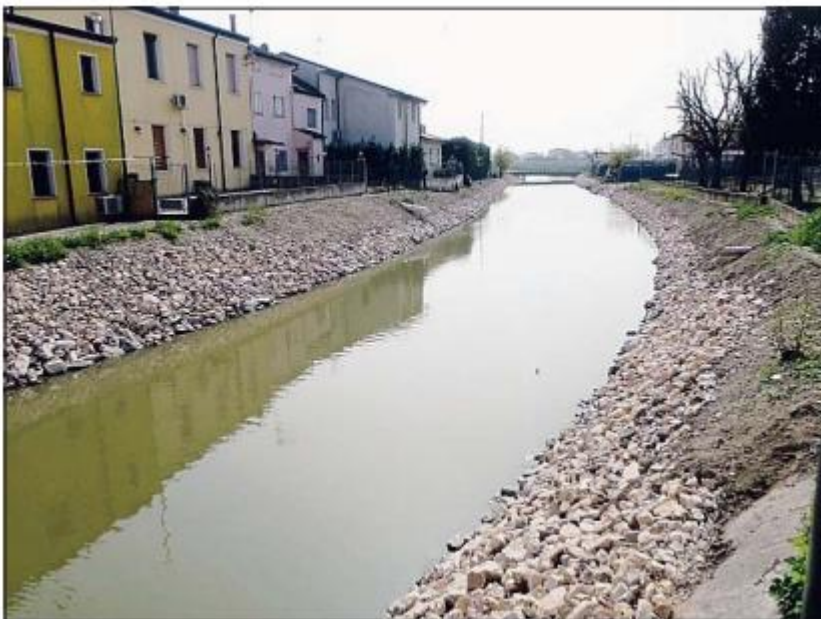
Il canale Crespino dopo l'intervento
