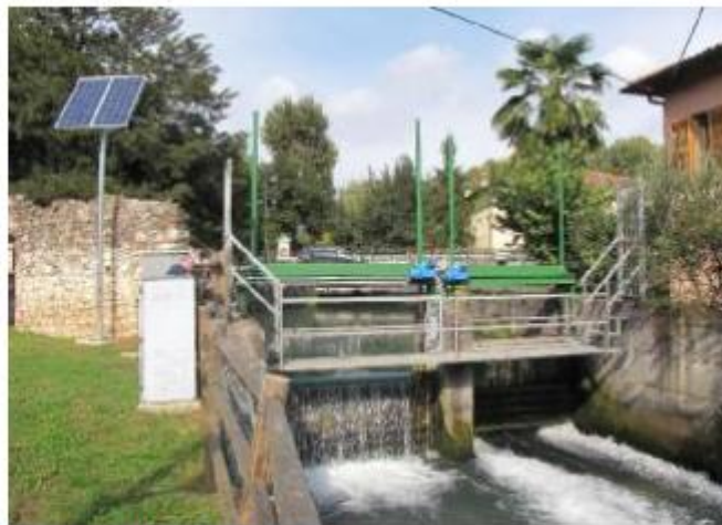
Paratie per il controllo del Fibbio
