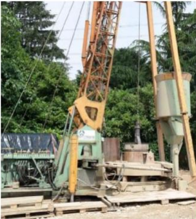
Previsto un intervento di recupero per il pozzo Benincà. BILLO
