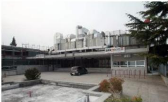
Lavori d'urgenza al palasport di via Goldoni dopo le infiltrazioni
