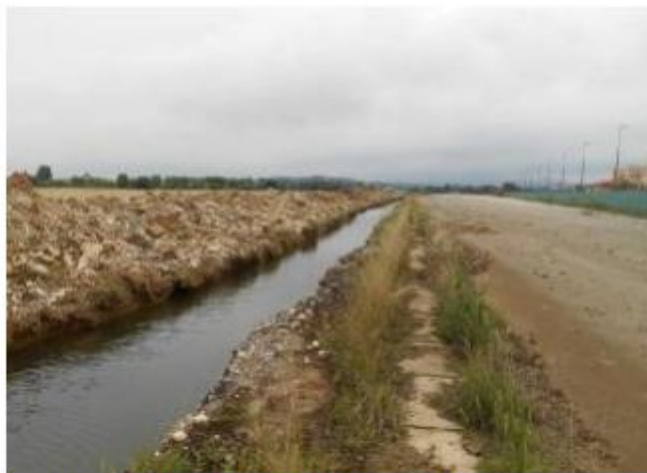
Il canale di scolo ha drenato 500 mila metri cubi di acqua
