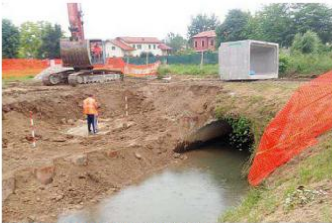
I lavori del consorzio di bonifica Brenta a Caselle
