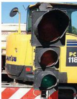
Lavori di asfaltatura in corso
