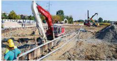
Il cantiere per costruire lo scolmatore Fossetta
