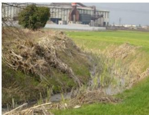
Il fosso Pila Vallese che viene costantemente monitorato
