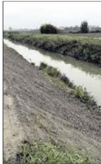
VIA TRIESTE Ripristino effettuato
