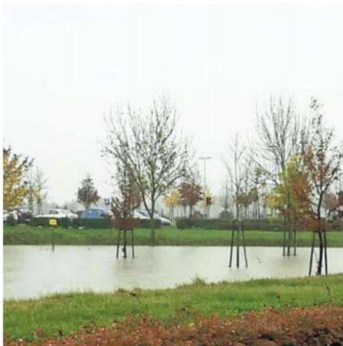
Canali sopra il livello a Portogruaro
