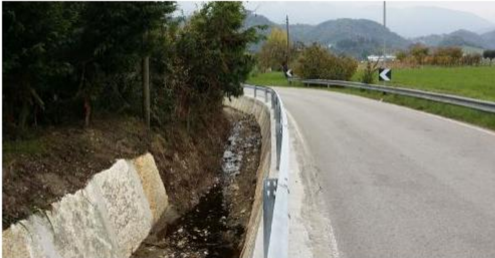
I lavori del Consorzio di bonifica Brenta in corso lungo via Boscaglie. FOTO PIGATO
