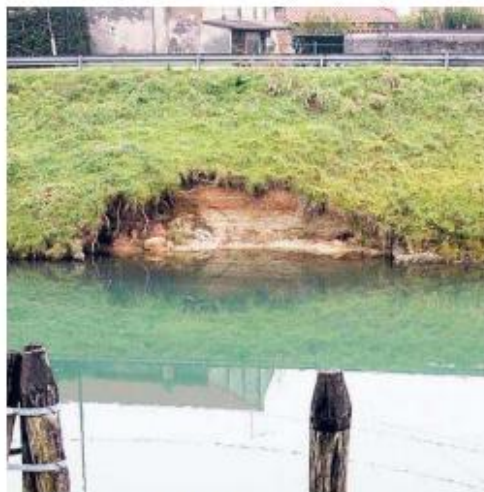
La situazione degli argini a San Lazzaro e poi tra Camin e Noventa Padovana: diversi sono i segni di indebolimento
