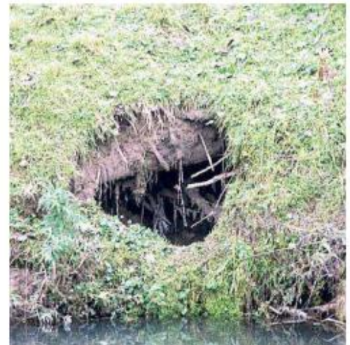
La situazione degli argini a San Lazzaro e poi tra Camin e Noventa Padovana: diversi sono i segni di indebolimento
