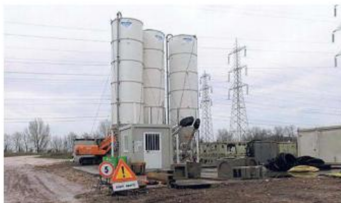
Il cantiere per l'interramento aperto e poi subito chiuso
