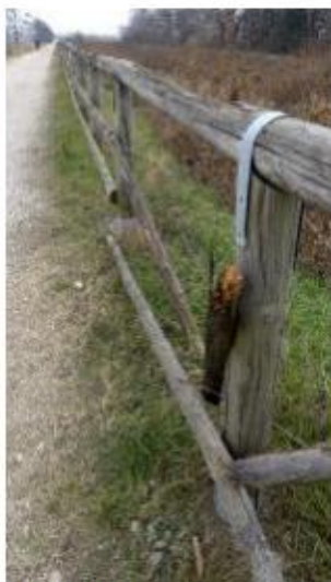
Un tratto danneggiato
