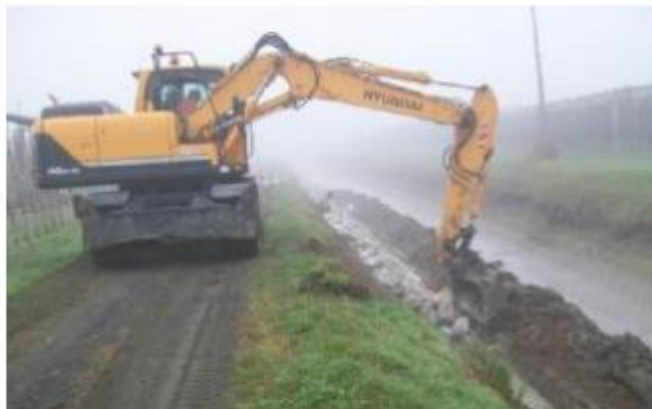
Una ruspa del Consorzio di bonifica Alta Pianura Veneta al lavoro
