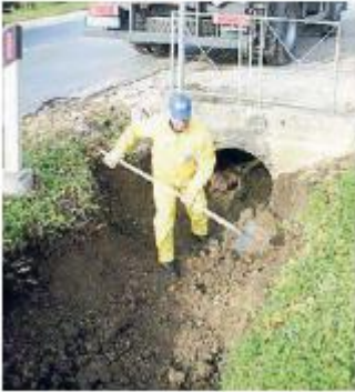
Manutenzione dei fossati
