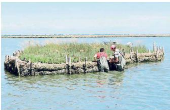
Una barenea rinforzata con le fascine di ramaglie in laguna nord
