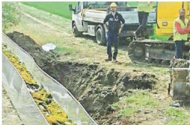
Le operazioni di bonifica del terreno e del canale Desturo in via Vanzo
