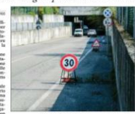
IL SOTTOPASSO FORLANINI in via Corrida a Portofino. In alto: il cantiere in via Corrida a Portofino.
