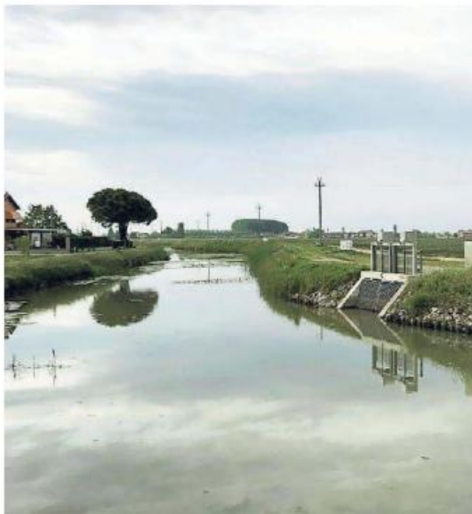
Un tratto del canale Altipiano, partono lavori per sette milioni
