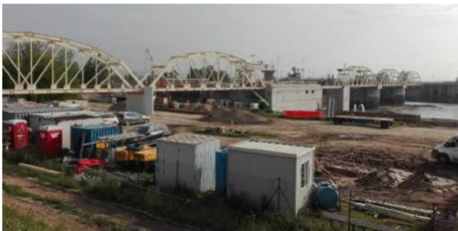
Il ponte passerella sull'Adige costruito a San Giovanni Lupatoto
