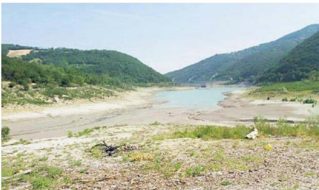
La drammatica situazione della diga di Mignano (Piacenza) con una forte diminuzione del livello dell'acqua
