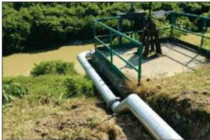
TEMPESTIVA Le piazzole sul fiume Monticano per la posa delle idrovore
