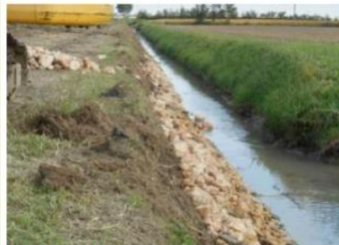
Lavori di arginatura
