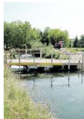
BLOCCO dei lavori in corso
