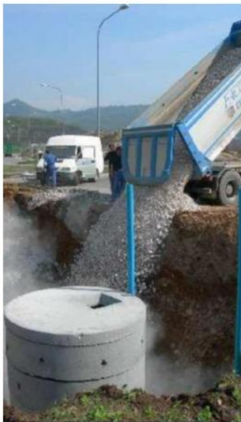
Il pozzo bevitore costruito a Cornedo, nel Vicentino, e interrato
