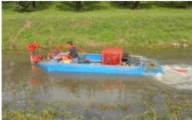
Una fase dei lavori che hanno interessato il collettore Zerpano
