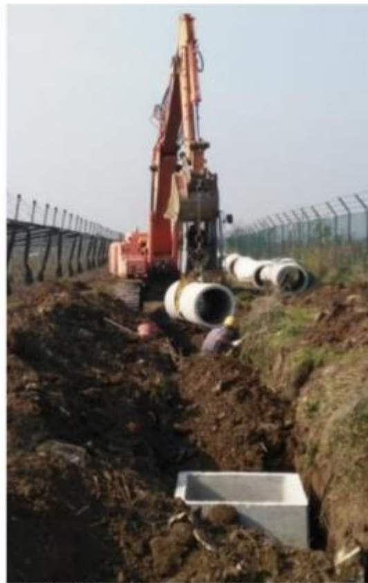
Un cantiere del Consorzio per la posa dei tubi
