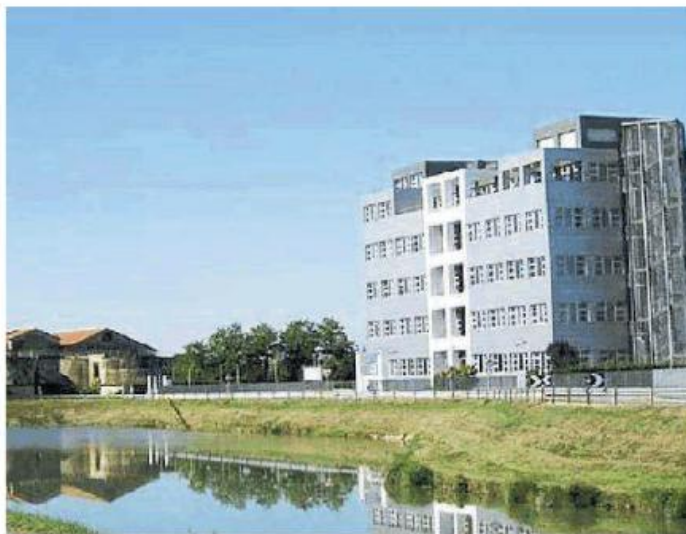
L'immobile realizzato dall'impresa Pavan è ancora inutilizzato
