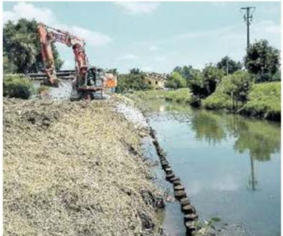
INTERVENTI Operai sul canale Tergola a San Giorgio delle Pertiche
