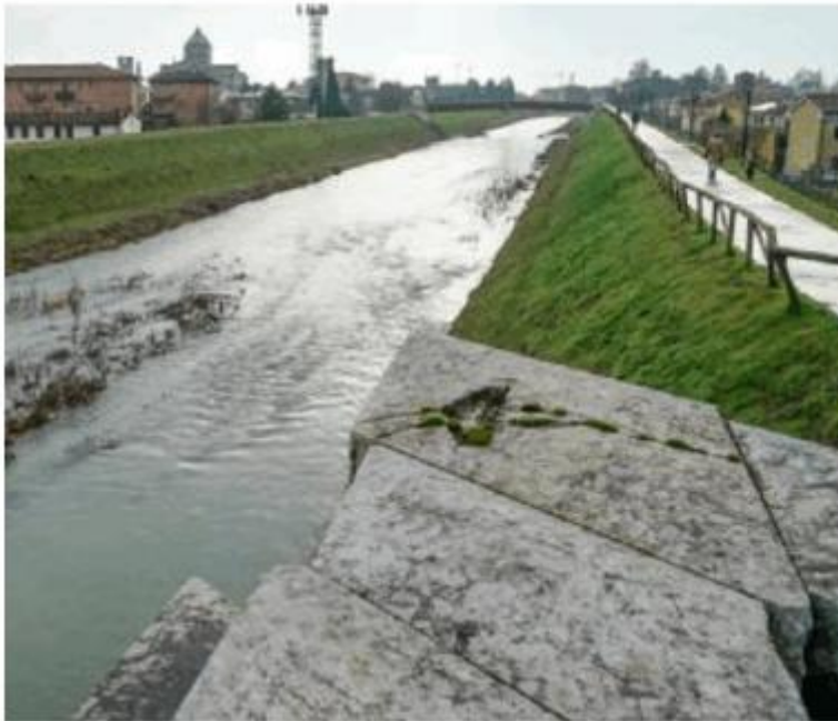
L'intervento prevede anche il proseguimento della pista ciclabile
