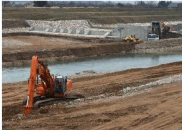
I lavori per la realizzazione del bacino a Trissino. FOTOSERVIZIO MASSIGNAN
