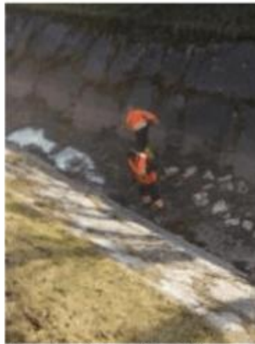
I lavori nell'alveo del Boldoro
