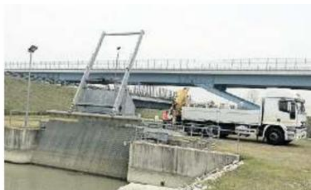
LADRI E VANDALI L'impianto idrovoro e il camion presi di mira
